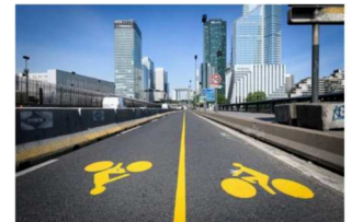
Aménagement cycliste temporaire du Pont de Neuilly
